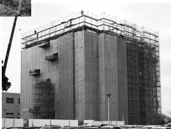
亥鼻キャンパスの建設中の二期棟
