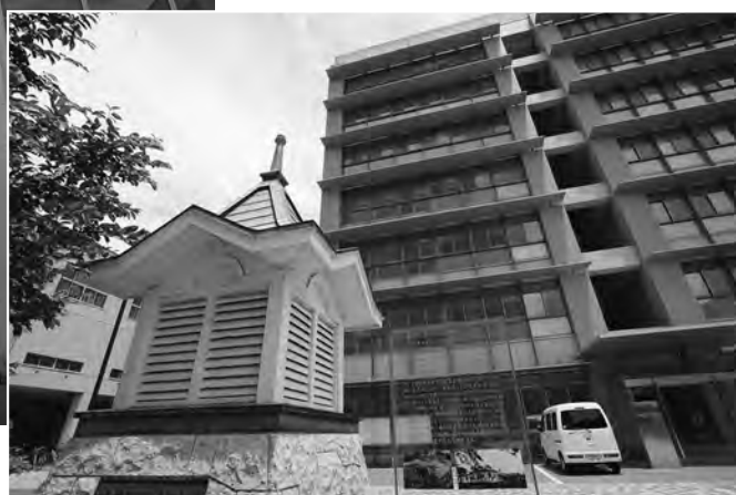
薬学部 医薬系総合研究棟 II と屋根飾り
